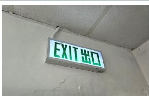
▲ 每年進行一次保養及檢查，確保緊急出口指示燈正常運作
