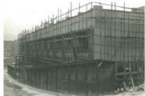
興建中的聖公會麥理浩夫人中心外觀。 The S.K.H. Lady MacLehose Centre during its construction phase.
